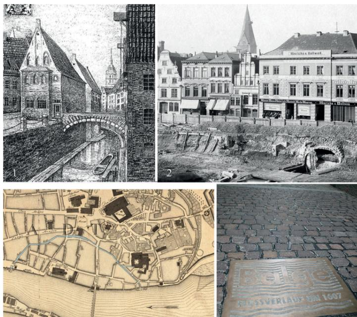
1. Rekonstruierte Ansicht einer Balgebrücke; 2. Sichtbarer Balgebrückenbogen freigelegt beim Bau der Baumwollbörse 1899; 3. Verlauf der Balge im Murfeldplan 1796; 4. Im Pflaster der Schüttingstraße markierter Verlauf der Balge.
