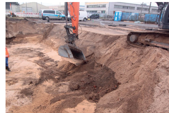
Mitarbeiter von der Landesarchäologie und vom Kampfmittelräumdienst beobachten die Baggerarbeiten auf der Baustelle
