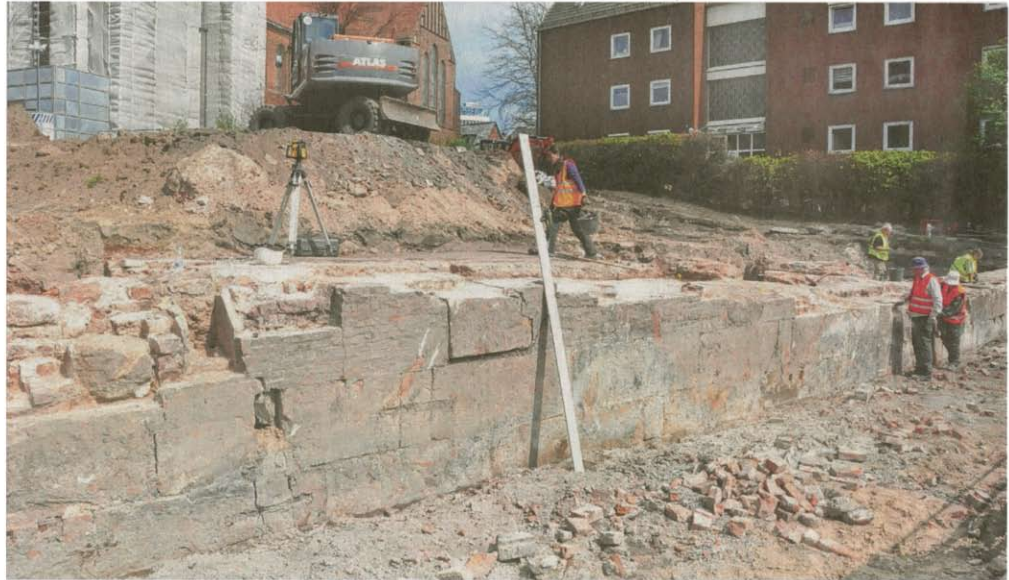
Freigelegt: ein 30 Meter langes Teilstück der alten Kai- und Stadtmauer in Höhe der Stephanikirche.
